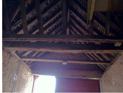
Etat actuel de la charpente
