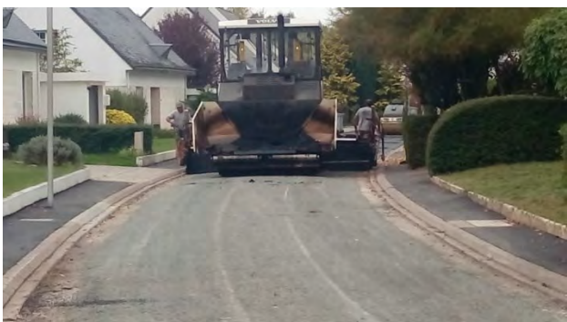
Pendant les travaux
